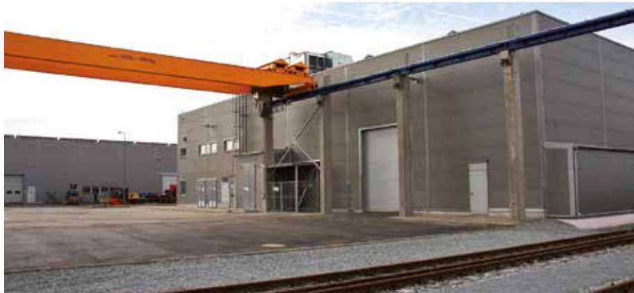
Hala pro svařování s jeřábem pro manipulaci kompletních hrubých staveb kolejových vozidel
