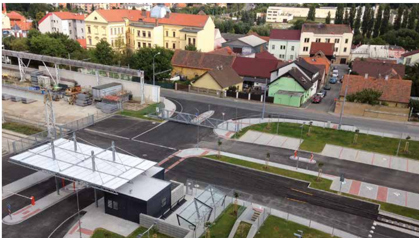
Nová podoba vjezdu a vstupní části areálu
