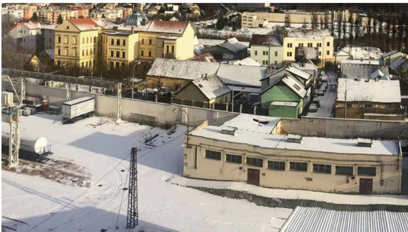
Podoba vstupní části areálu před výstavbou a rekonstrukcí
